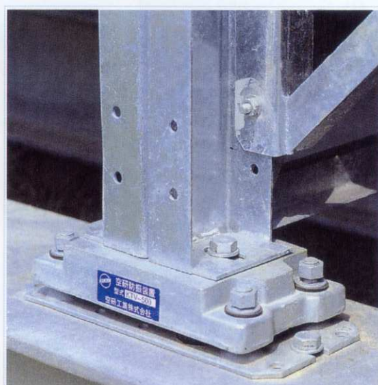
多联体连接部分装配实例
