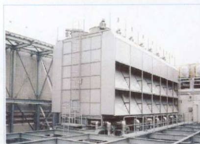
密闭式冷却塔兼加热塔 (日本国内独家技术)
