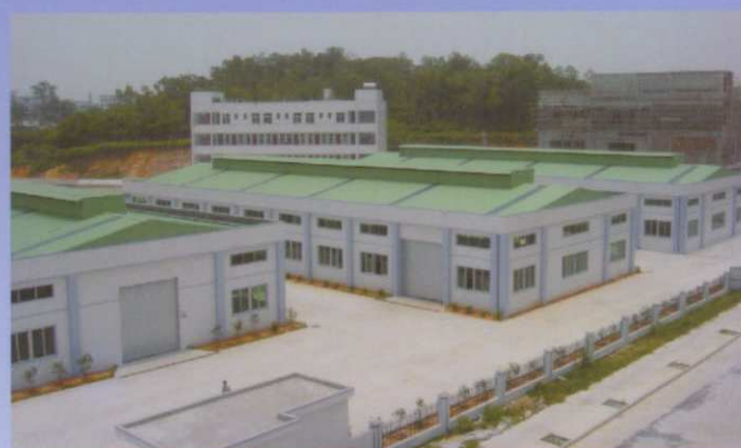
■ 东莞空研冷却塔有限公司厂房
